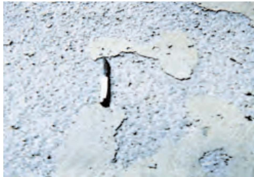
تقشر سطح الخرسانة نتيجة عدم استخدام مولدات الفقاعات ضمنها، عند تعرضها لأملاح الازابة.
